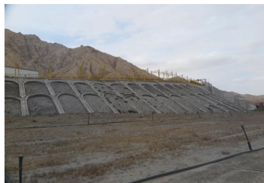
采运矿调度中心拱形边坡
