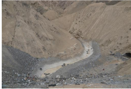
水闸东沟排废场排洪涵洞
