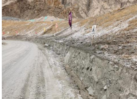
黄龙沟排土场挡土墙
