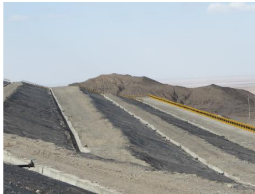
二号尾矿库子坝排水渠
